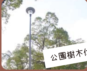
西側土手街灯設置(8箇所)
