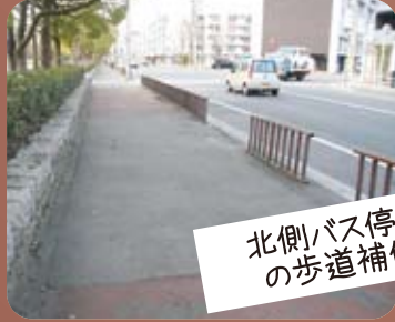
整地・陥没補修
